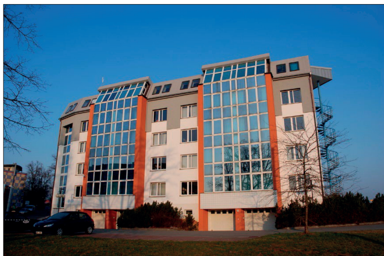
Budova NC | budova pedagogů kontakt na vrátnici +420 585 636 090
